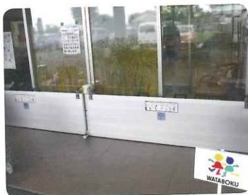
玄関扉に設置した止水板
